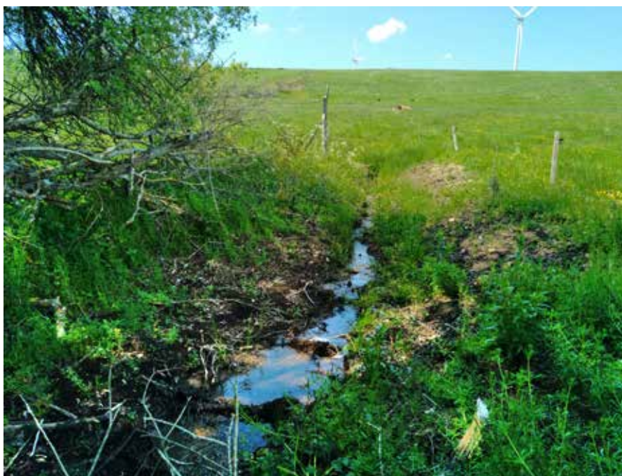
Rase végétalisée à écoulement diffus
