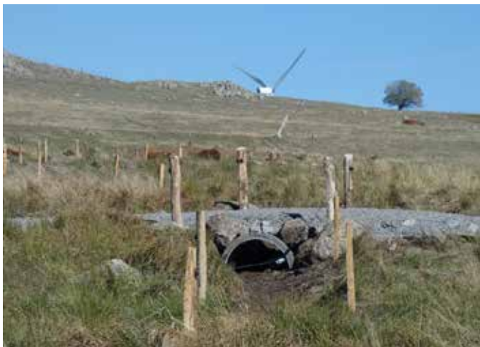
Franchissement en arche demi-buse avec petit enrochement de stabilisation
