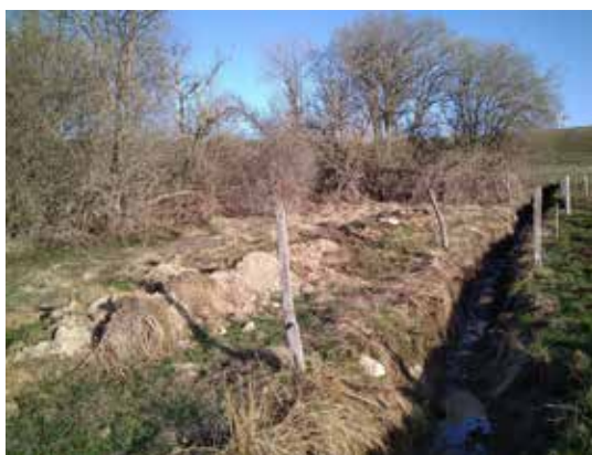
Fossé drainant large et profond
