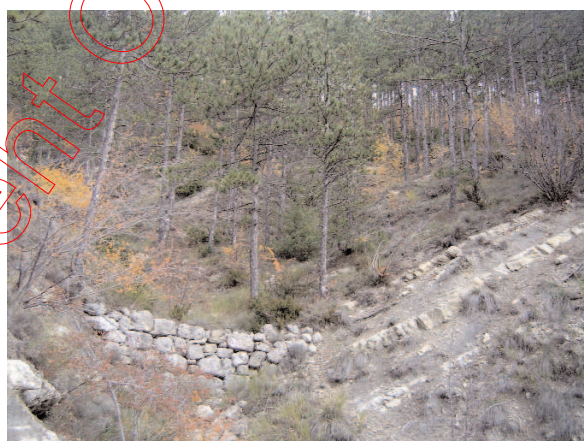
Reboisement et ancien seuil RTM, FD Chamouse (26)
