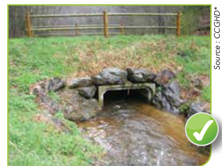
Buse cadre enterrée au 1/3
