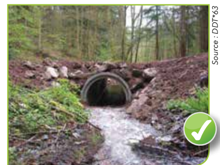
Buse circulaire enterrée au 1/3
