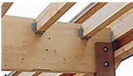
Réalisé à partir de bois résineux (épicéa, sapin, pin sylvestre) abouté ou non, le Bois Lamellé-Collé dont les lamelles ont une épaisseur comprise entre 2 et 40 mm. Collé face contre face, ce procédé permet aussi d'obtenir des pièces de dimensions supérieures à celles autorisées en bois massif.
